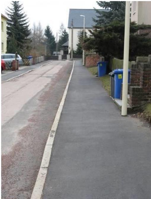
Nach der Verlegung von Elt-Kabel durch die Stadtwerke Glauchau wurde im Rahmen einer Kostenbeteiligung der komplette Gehweg mit einer neuen zweilagigen Bitumenschicht versehen. Durch dieses Mitwirken konnte die gesamte Gehwegbreite beseitigt werden, da das Versorgungsunternehmen nur dazu verpflichtet ist, seinen Rohrgraben wieder zu verschließen. Kosten der Maßnahme 6720,- €.
