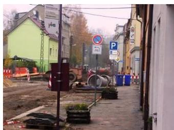
Um den heutigen Anforderungen gerecht zu werden, wurde die Gehwege neu mit einer Breite von 2,50 Meter angelegt. Hier erfolgte die Oberflächenbefestigung mit Betonsteinpflaster. Im Bereich der Wehrdigtschule befindet sich eine separate Fahrspur zur Erhöhung der Sicherheit des Schülerbring- bzw. -abholverkehrs. Gleichzeitig wurde der Parkplatz im Bereich der Wasserstraße erneuert.
