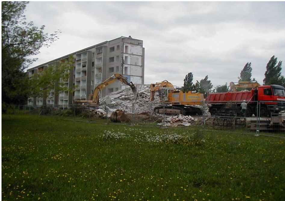
Sachsenallee 62 - 72 mit Abtransport von Bauschutt
