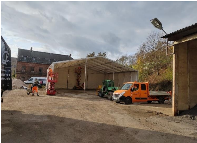
Aufbau der Zeltkonstruktion
