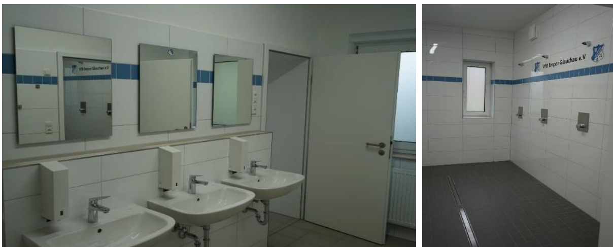
Neu errichteter Vorraum zum Duschbereich mit neuen Wascheinheiten und einer direkten Verbindung zu den neuen WC-Bereichen. Neu errichteter Duschbereich mit 6 Duschen
