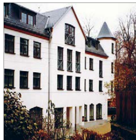
Abriss und Neubau des Eckhauses Foto: Sammlung W. Haueisen
