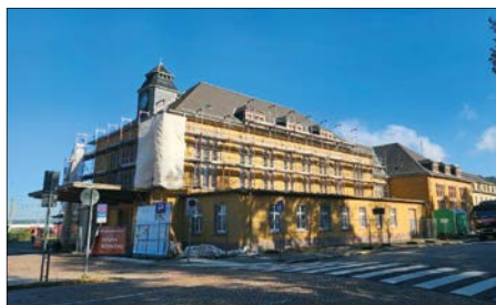
Das noch eingerüstete Bahnhofsgebäude
