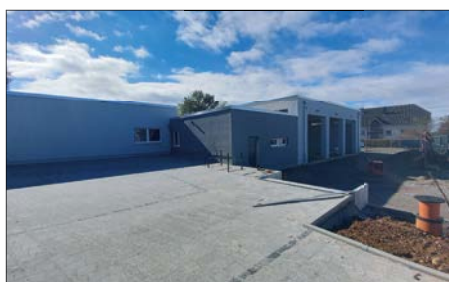
Blick auf die Fahrzeughalle an der Ringstraße Reinholdshain
