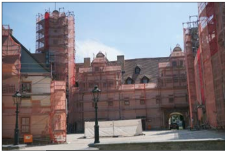
Die Ansicht der Schlossfassade vor und während der Sanierung.
