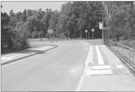
Ausgebaute Glauchauer Straße in Niederlungwitz, Foto: Stadt Glauchau
