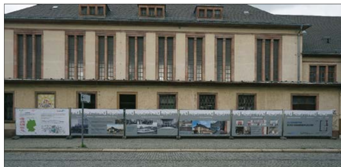
Der gestaltete Bauzaun am zu sanierenden Bahnhofsgebäude
