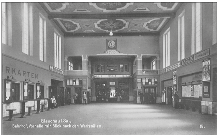
Bahnhof, Vorhalle mit Blick nach den Wartesälen – Sammlung Hauseisen
