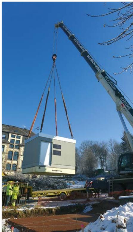
Die Verteilstation wurde mittels Schwerlasttransporter angeliefert und mit Krantechnik aufgestellt.
